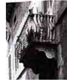
Casa Già Bettoni Via S. Urbano 5 (BS)
