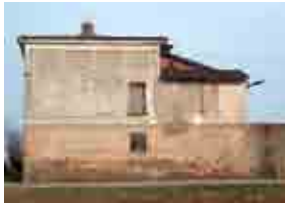
Palazzo Monticelli Via Monticelli 1030@27
