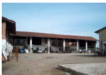
Fienile Gazzi Via vecchia per Pontoglio 23 1340@23
