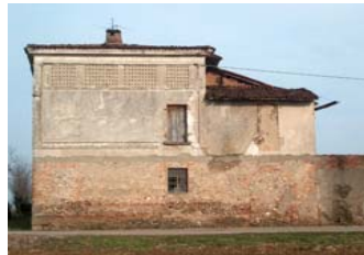
Palazzo Monticelli Via Monticelli 27 1030@27
