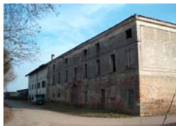
Palazzo Monticelli Via Monticelli 1030@27
