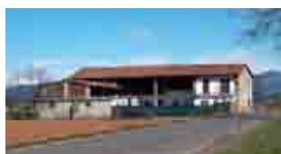
Cascina Inguassanella Via Sala 23 1540@23
