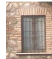
Cascina Tosini (Pozzolengo)
